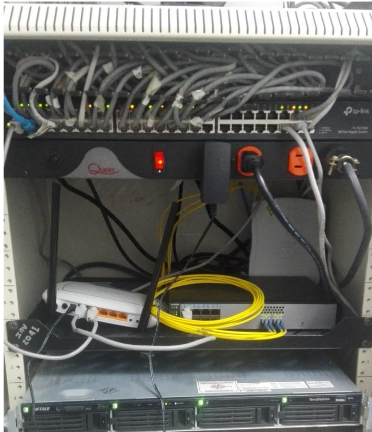
IMAGEN: Se puede visualizar router, modem, Switch y servidor buffalo.
