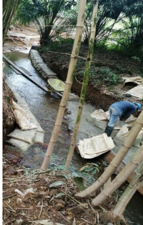
Imagen 05. Encauce con bolsacreto del caño al interior de la PTAP
