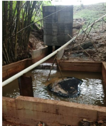
Fuente: Aguas De Barrancabermeja S.A. E.S.P.
