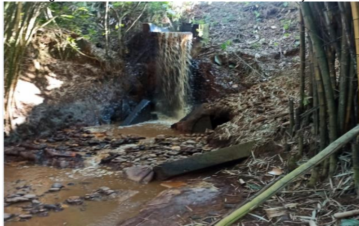
Fuente: Aguas De Barrancabermeja S.A. E.S.P.
