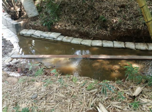
Imagen 05. Encauce con bolsacreto del caño al interior de la PTAP
