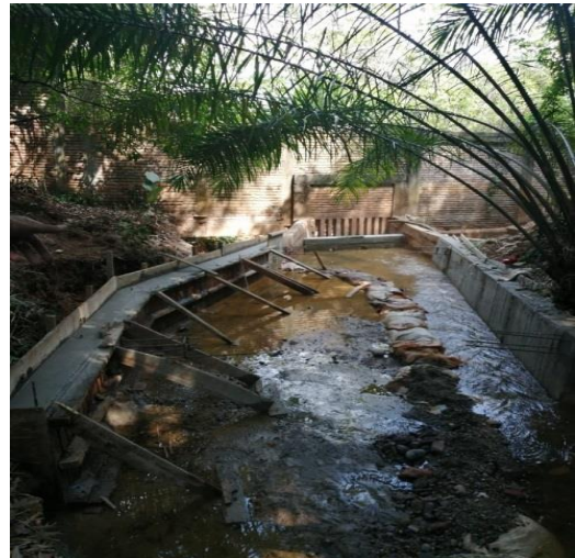
Imagen 06. Adecuación estructura final de descarga para ubicación de balsas superficiales de Fito remediación.
