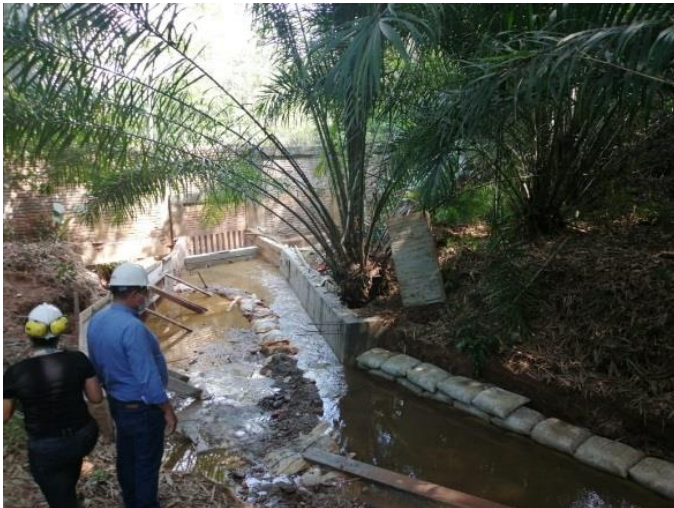
Imagen 06. Adecuación estructura final de descarga para ubicación de balsas superficiales de Fito remediación.
