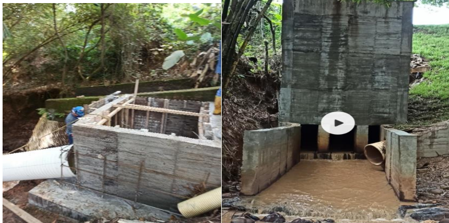
Fuente: Aguas De Barrancabermeja S.A. E.S.P.
